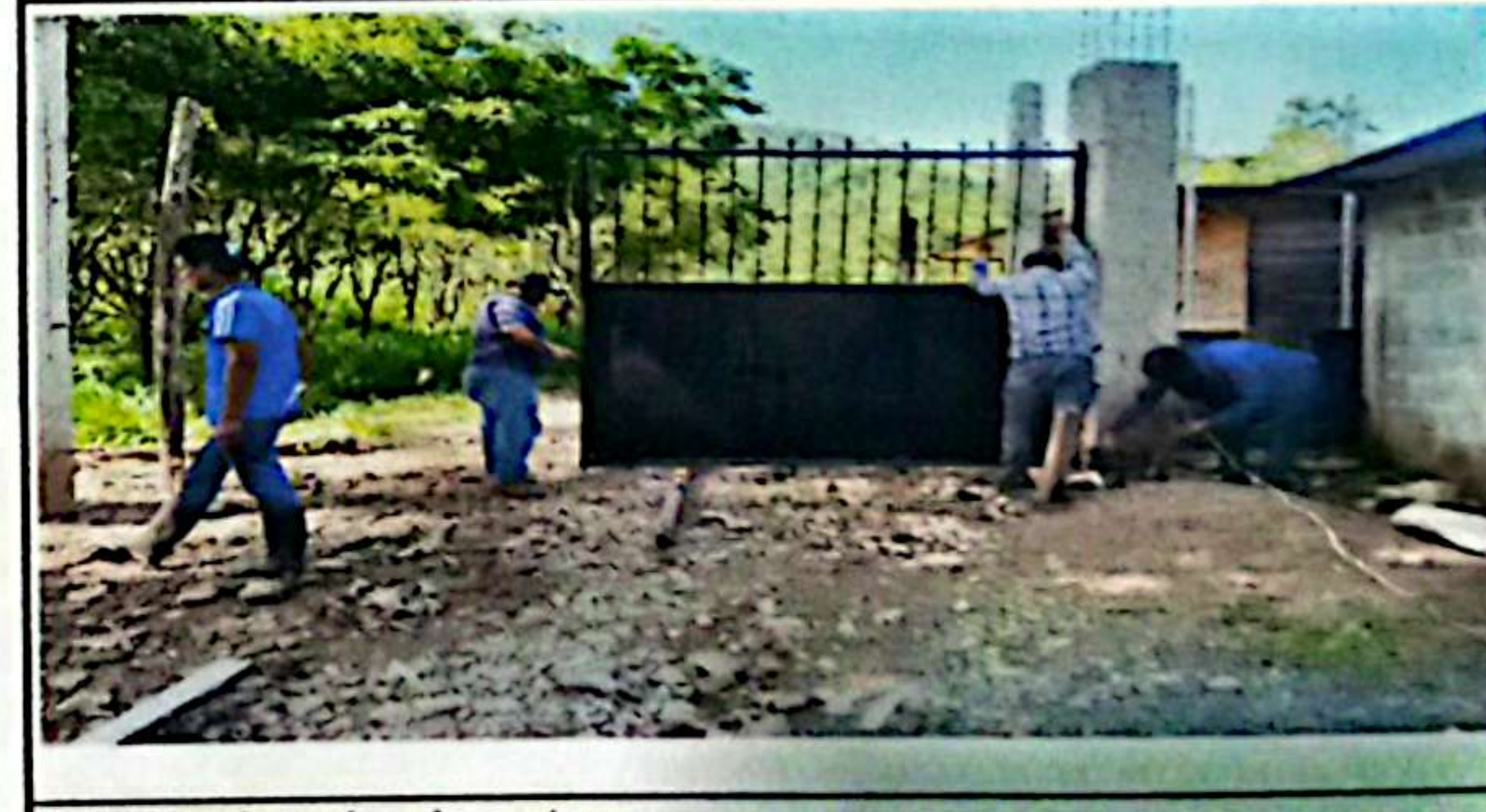
Foto 6: colocacion de porton
