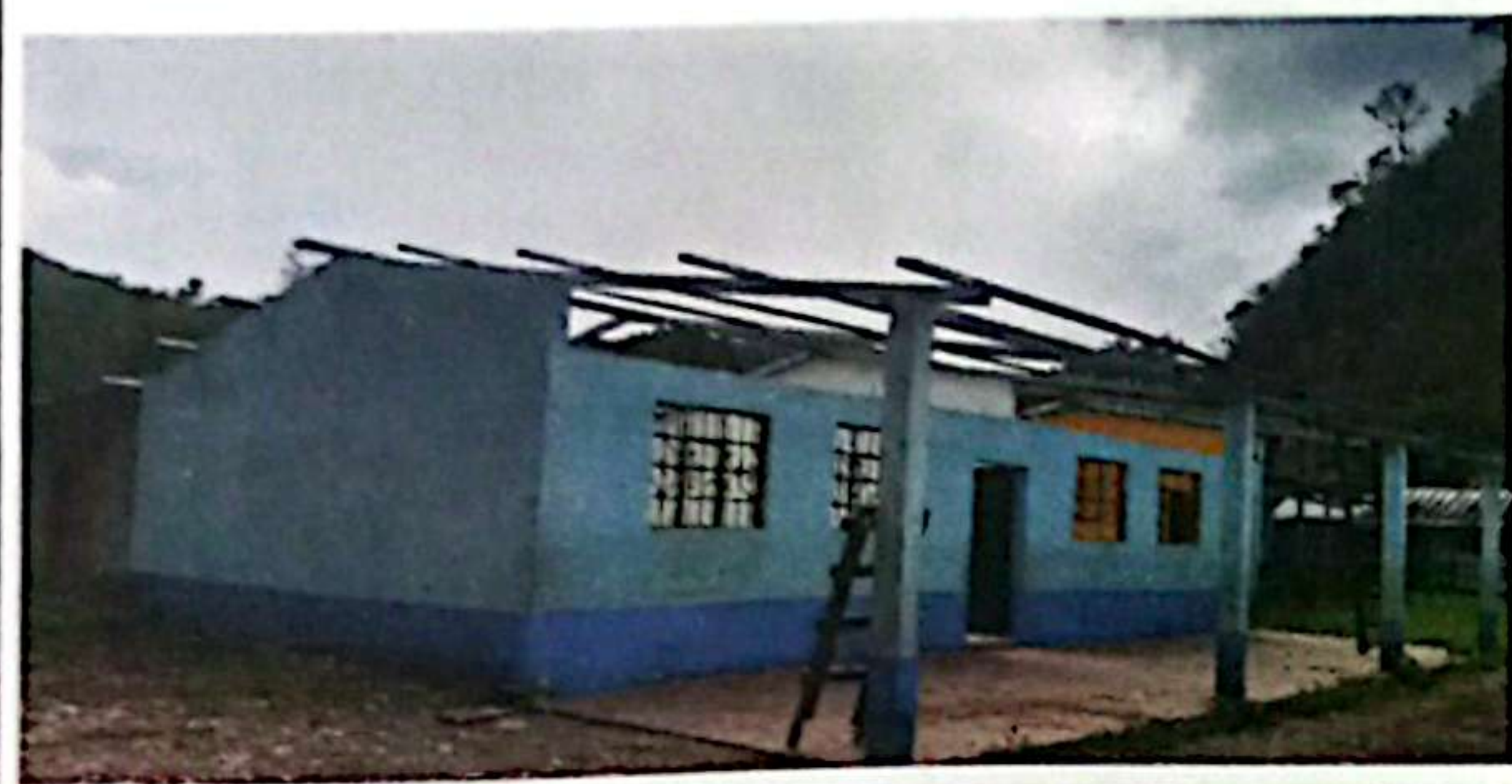
Foto 3: proceso de colocacion de techo
