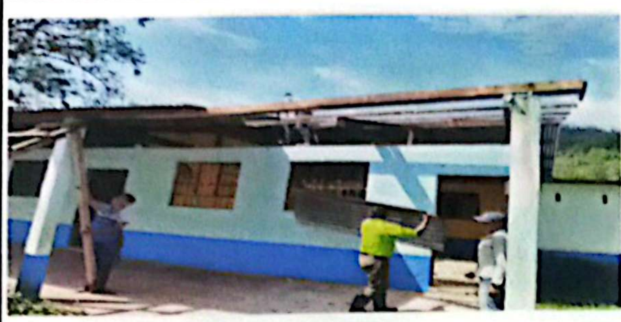
Foto 1: Quitando las laminas en mal estado
