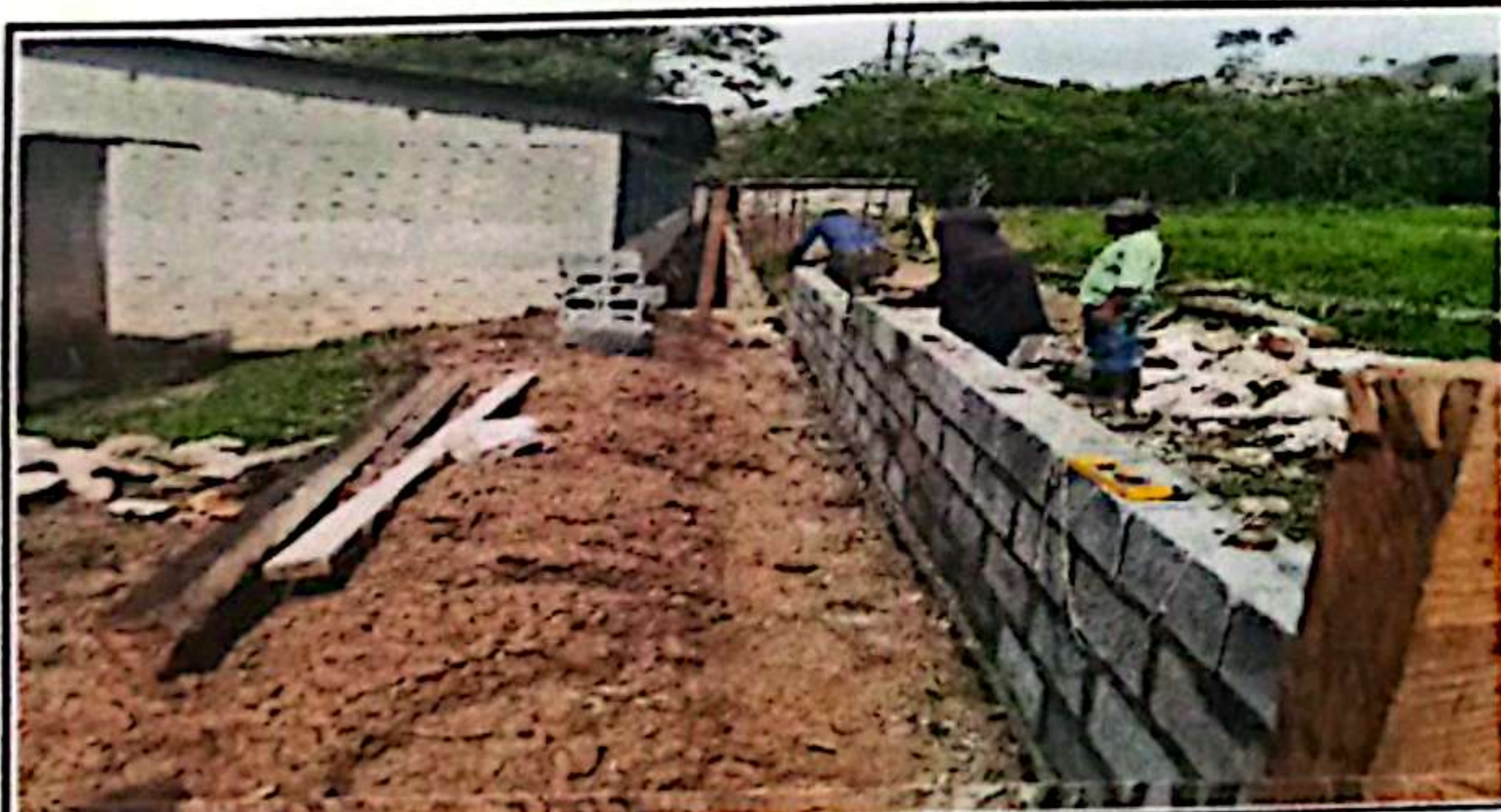
Foto 5: Inicio de trabajo de muro perimetral
