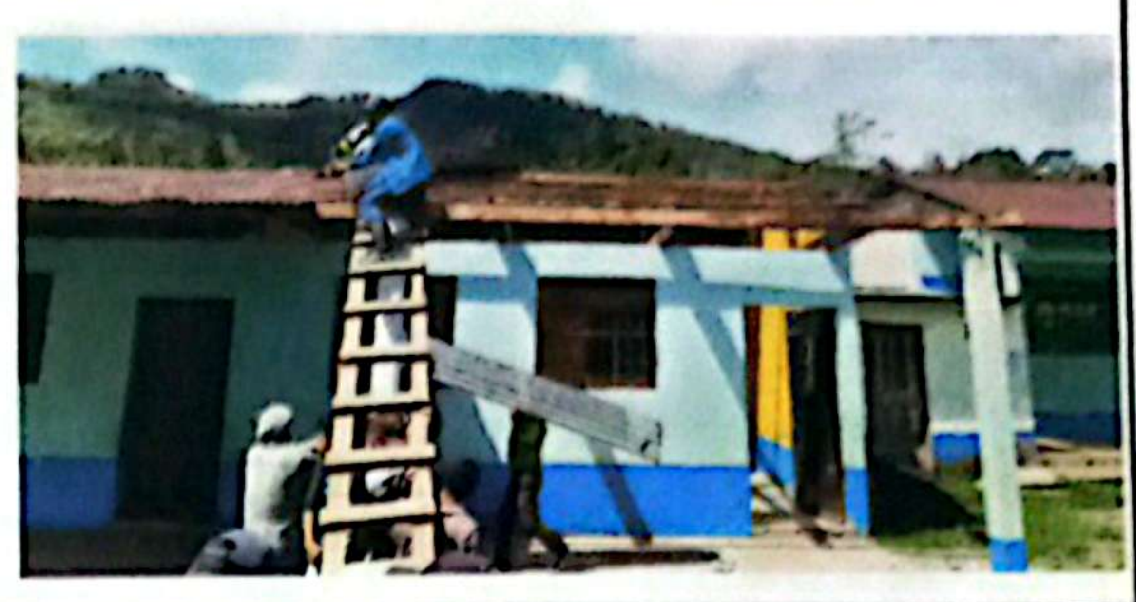
Foto 2: quitando vigas en mal estado
