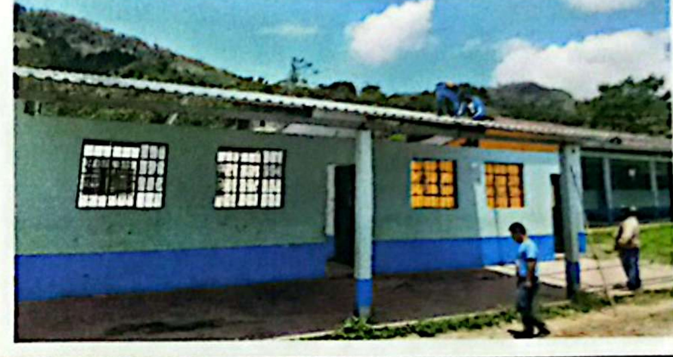
Foto 4: colocando laminas nuevas
